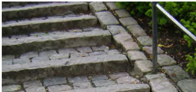
Kantsten kan anvendes ved alle typer af anlægsopgaver. Her som trappeforkant i kombination med chausséstén. Smuk og tidløs løsning.
